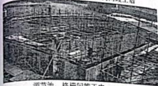
调节池、格栅间施工中
