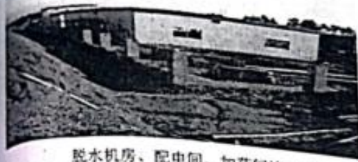
脱水机房、配电间、加药间竣工后
