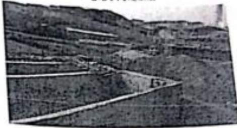
后组合池施工中
