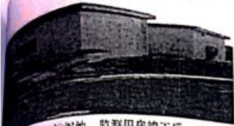
取水池、污泥池、监测用房竣工后
