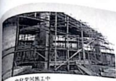
电化学槽施工中
