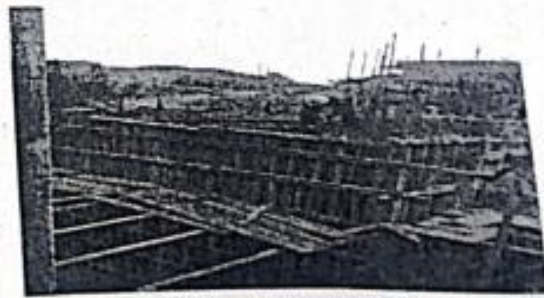
回用水池、污泥池监测用房施工中
