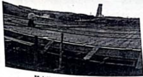
脱水机房、配电间、加药间施工中
