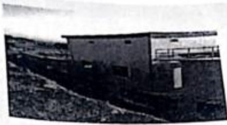
电化学槽竣工后
