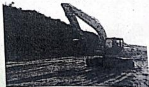
电化车间施工前
