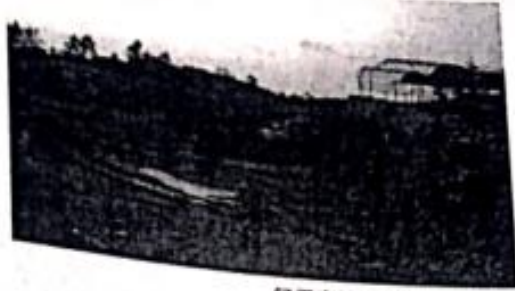
门卫室施工前
